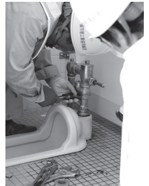
▲トイレの水洗設備の調整(甲南中学校)
