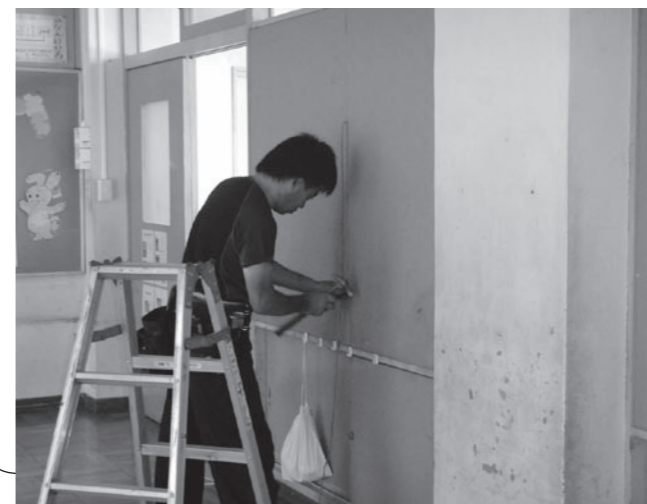
▲施設の修繕作業(信楽小学校)
