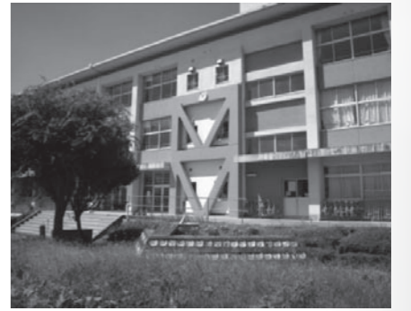
▲耐震補強工事を行った大原小学校
