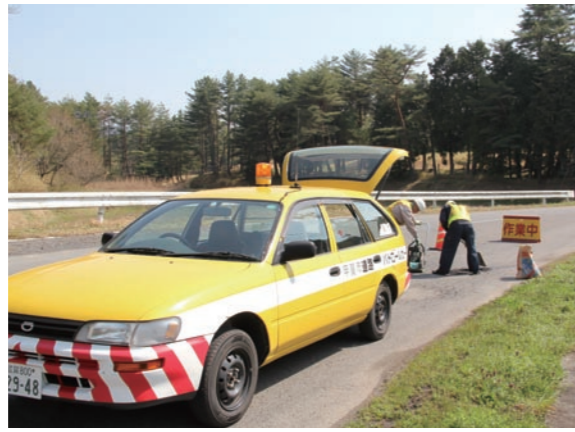
▲巡回・点検と簡易補修を行う道路パトロール
