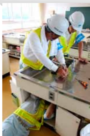
▲調理台の水もれ修理 (山内小学校)
