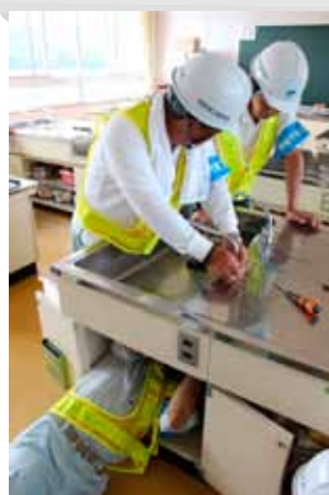
▲調理台の水もれ修理 (山内小学校)
