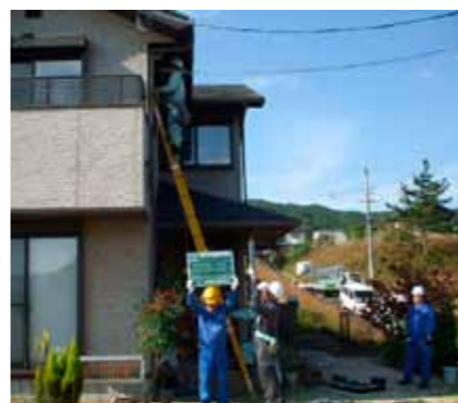
▲音声放送端末機設置工事の様子
