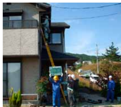
▲音声放送端末機設置工事の様子
