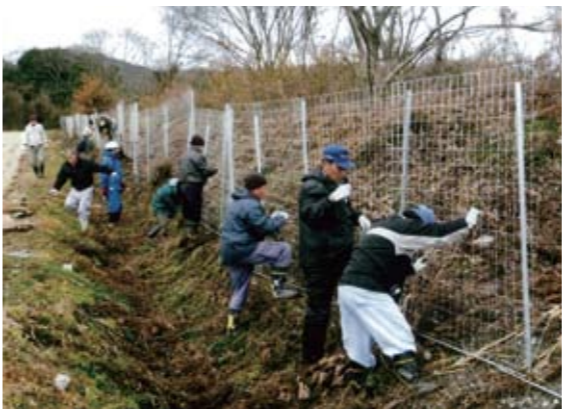
▲農作物への被害を防ぐため設置される鳥獣侵入防止柵
