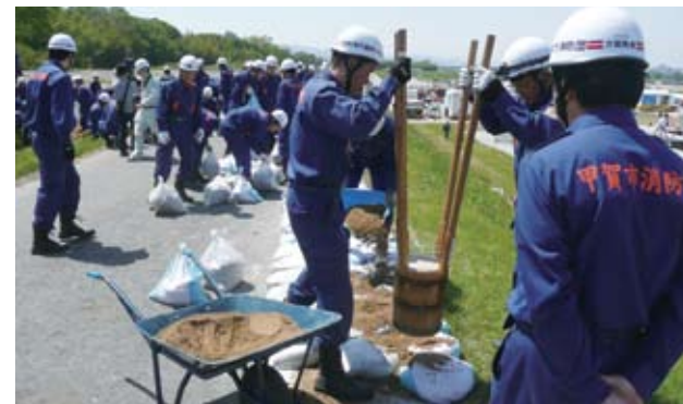
▲「積土のう工」訓練を行う水防団員
