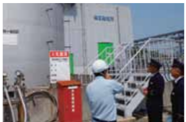
▲危険物を保有する事業所に対し実施された査察
