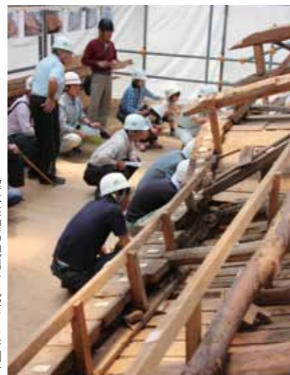
▶解体修理の現場を見学する参加者
