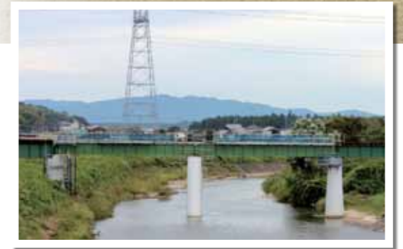
▲台風18号による災害で大きな被害を受けた杉川橋梁。復旧に向けた作業が急ピッチで進むなか完成した新たな橋脚と橋桁。
