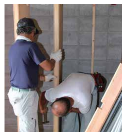
▲手際よく体育用具室に仕切りを設置する会員（伴谷東小学校）
