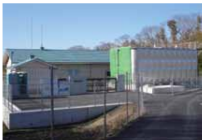
▲水質の安定確保のため設備が拡充された岩室浄水場
