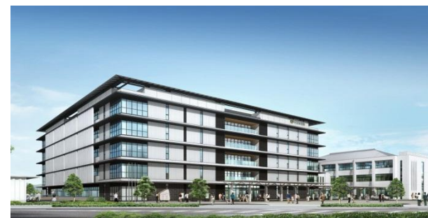
新庁舎 南東側外観イメージ
