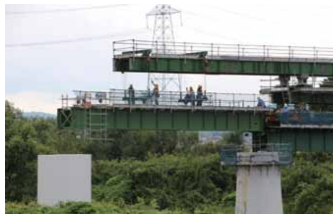
▲橋脚に新たな橋桁を懸架 (平成26年9月)
