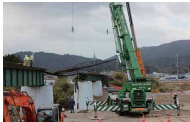
▲橋上に残されたレールの解体撤去 (平成25年12月)
