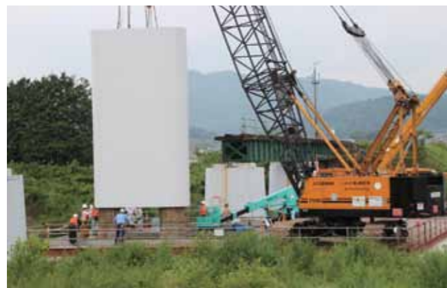
▲新たな橋脚の据え付け作業 (平成26年6月)
