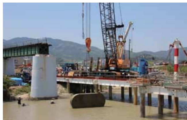
▲倒壊した橋脚土台部分を川底から撤去 (平成26年5月)
