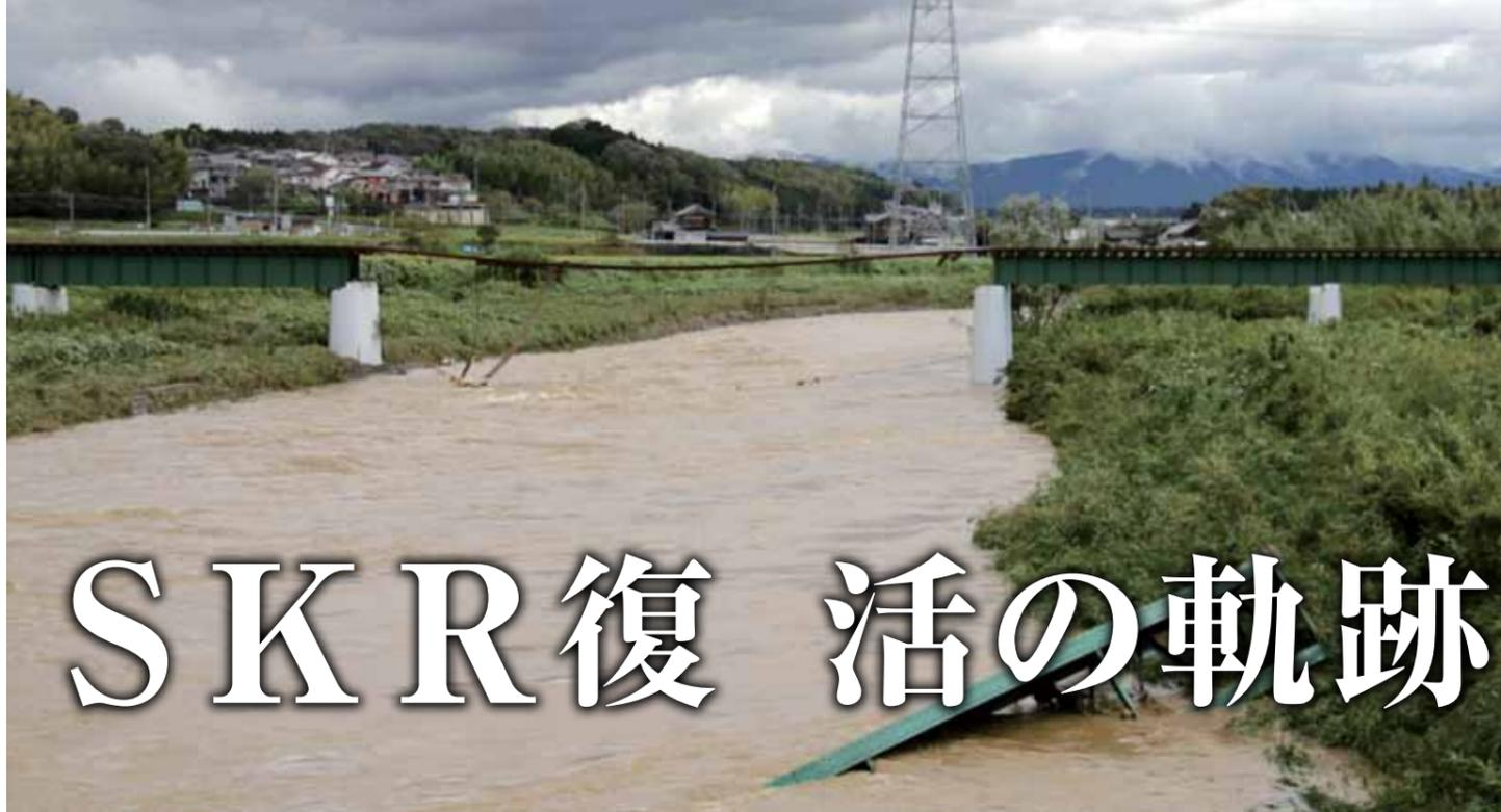
▶豪雨災害で橋脚と橋桁が流失した杣川橋梁
