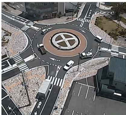
ラウンドアバウトの設置事例（出典：国土交通省中部地方整備局HP）
