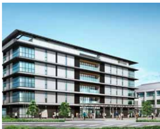
▲新庁舎 南東側外観イメージ
