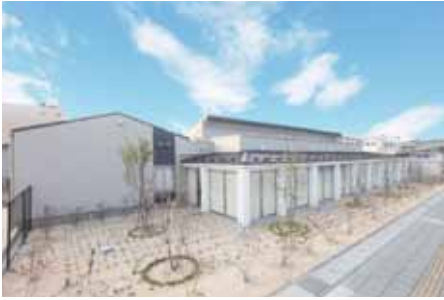
▲同社が新築工事を行った介護老人保健施設「ケアセンターささゆり」
