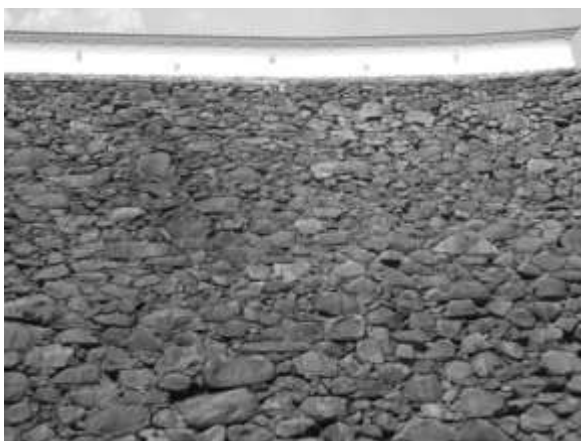
図 1 7 高さ約 2 0 m の稲荷曲輪東面石
