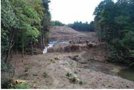
写真1 調査前の関津城跡
