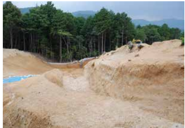
写真 15 城の南側の空堀と土塁
