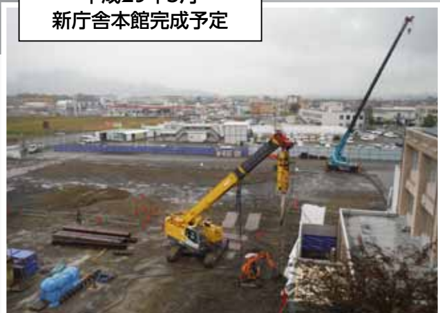
▲新庁舎建設予定地
