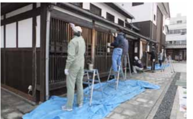
▲建物の外壁を塗装される有志の方々
