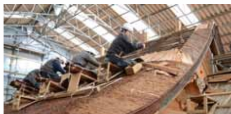
▲文化財修理には多くの職人さんの伝統的な技術が使われています。
