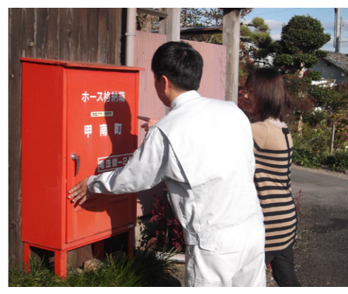
▲消防ホース格納箱の点検作業
