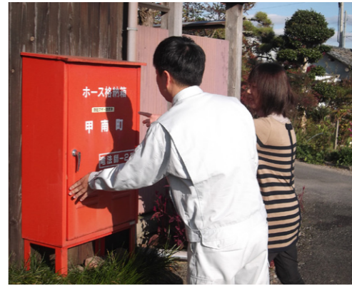
▲消防ホース格納箱の点検作業
