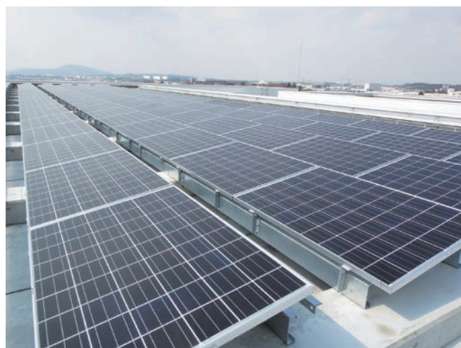
▲屋上の太陽光パネル
