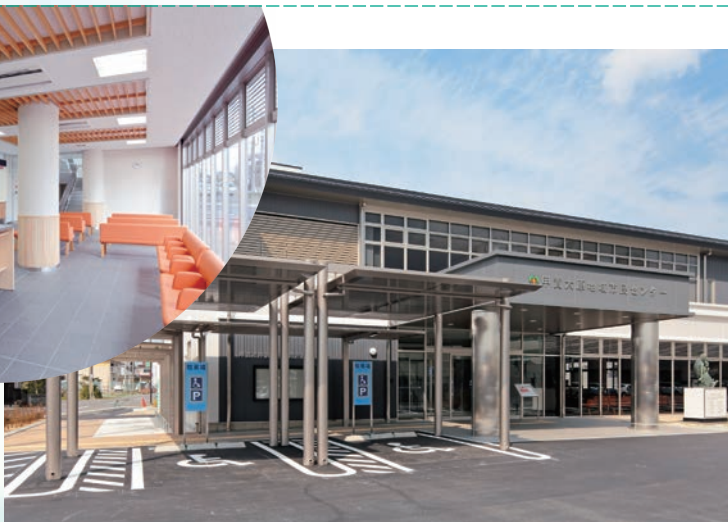
▲完成した甲賀大原地域市民センター
