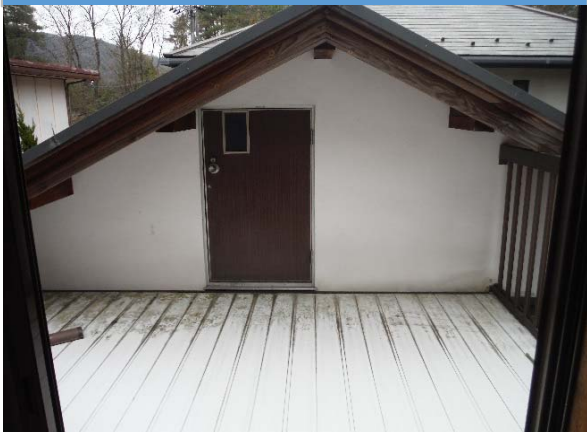
屋根裏収納入口
