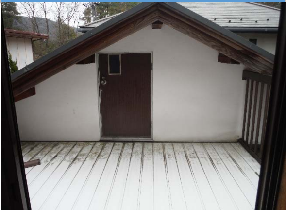
屋根裏収納入口
