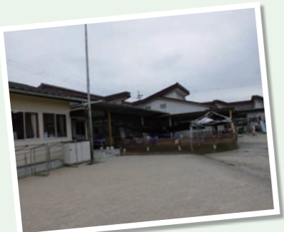
▲水口西保育園 園舎
