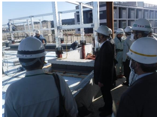
甲賀市まちづくり活動センター「まるーむ」 の工事技術監査
