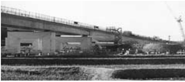
着々と進む第二名神工事（甲南インター付近）
