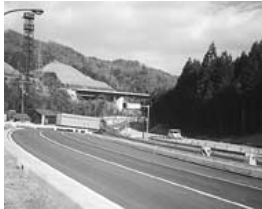
信楽 I.C. 附近の工事状況
