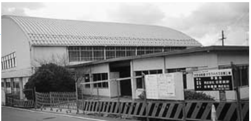
老朽化により改修が進められている甲南体育館
