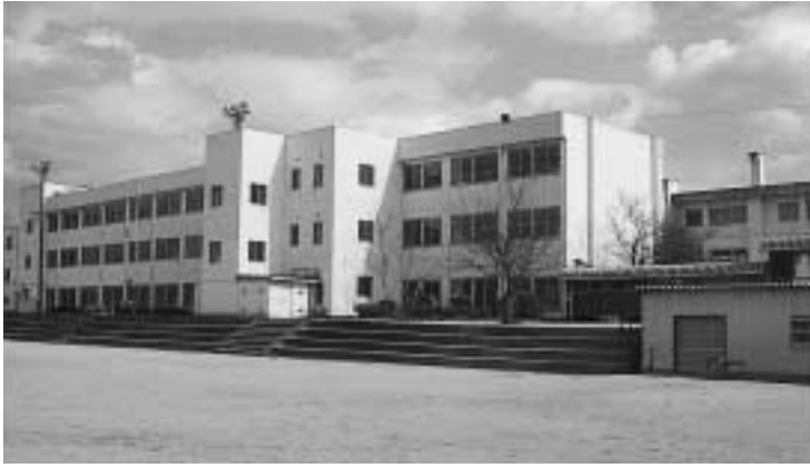
耐震補強、大規模改造計画の貴生川小学校
