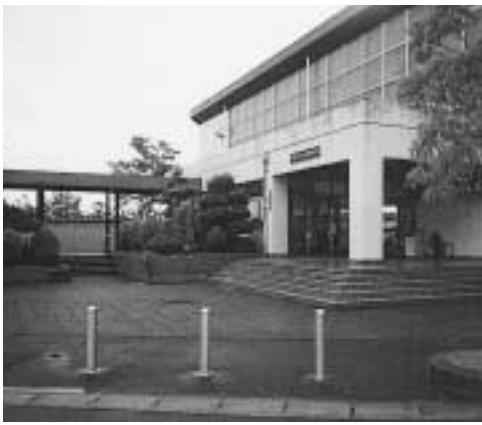
早期に改修が望まれる施設
