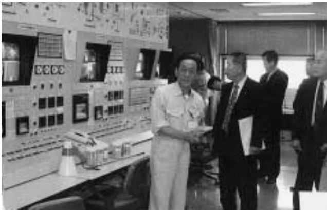
甲賀広域行政組合衛生センター 焼却場制御室
