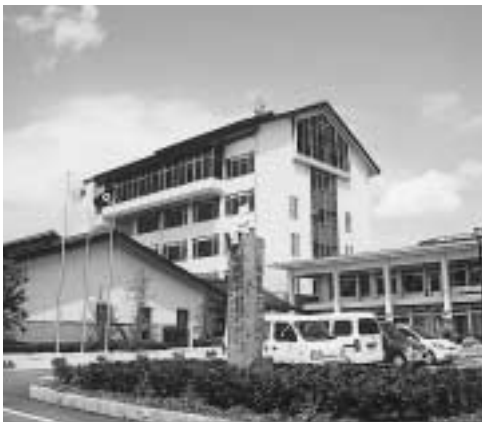
土山支所庁舎
