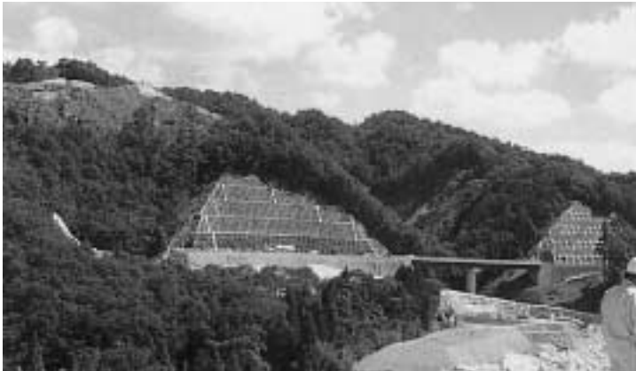
心配される付替県道・大津信楽線の工事
