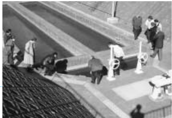
湖南市朝国にあるポンプ場 沈砂池の調査
