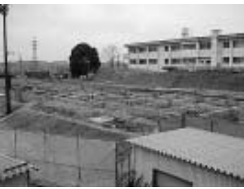
貴生川小耐震補強・改築工事
