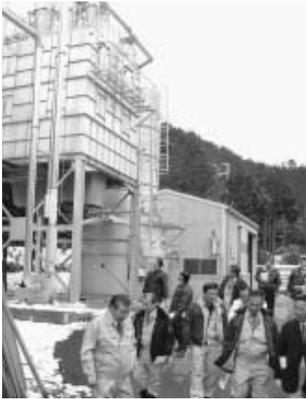
木質エネルギー施設
