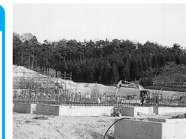
工事中の小原小学校校舎
