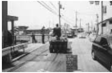
市道の補修工事は追いつかない状態
