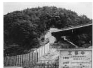
改良工事が始まった県道・大津信楽線
