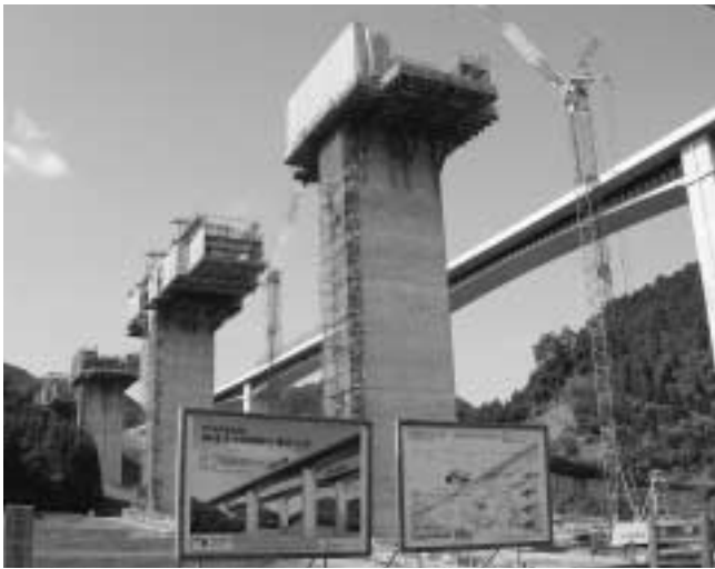
杉谷川橋の建設工事
