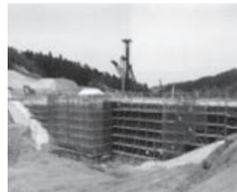
貯留構造物(ダム工)上流側で遮水シート施工中(黒い箇所)
