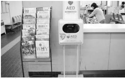
水口庁舎玄関に設置されている AED
