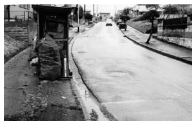
急がれる湧水部分の道路
