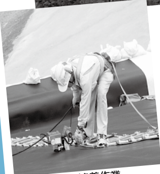
遮水シートの溶着作業
