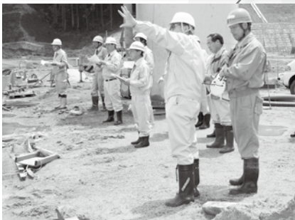
クリーンセンター滋賀建設現場
