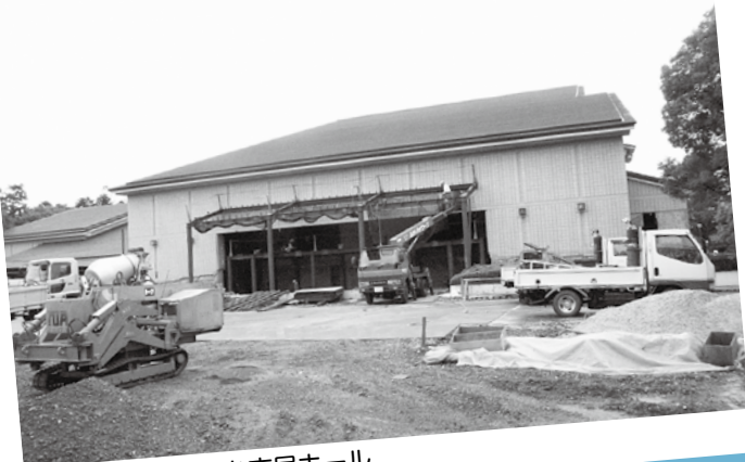
工事中のあいこうか市民ホール
