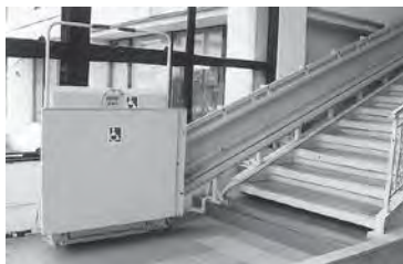
水口中央公民館の昇降機
