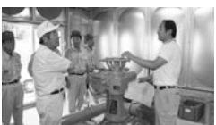
甲南中央配水池
