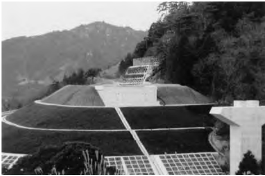
工事が中断したままの付替県道大津・信楽線
