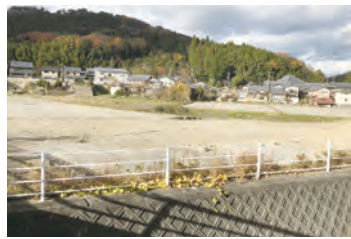
水道送水管事故現場である、水口第一水源
