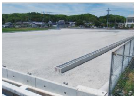
(仮称) 伴谷くじらこども園造成工事
