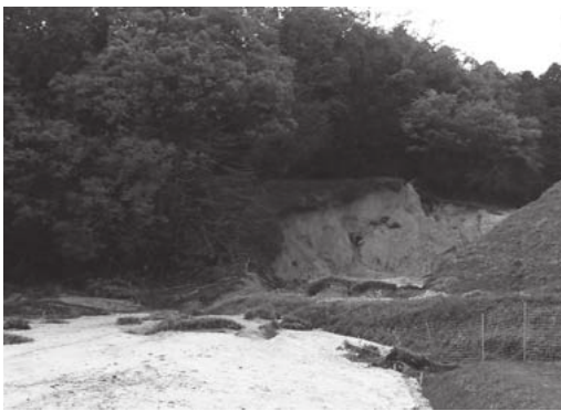
水口町下山のため池被災現場
