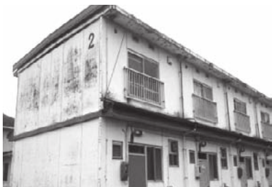
老朽化した南土山市営住宅の外壁
