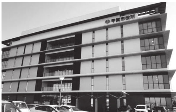
約67億円の合併特例債を活用して建設された新庁舎
