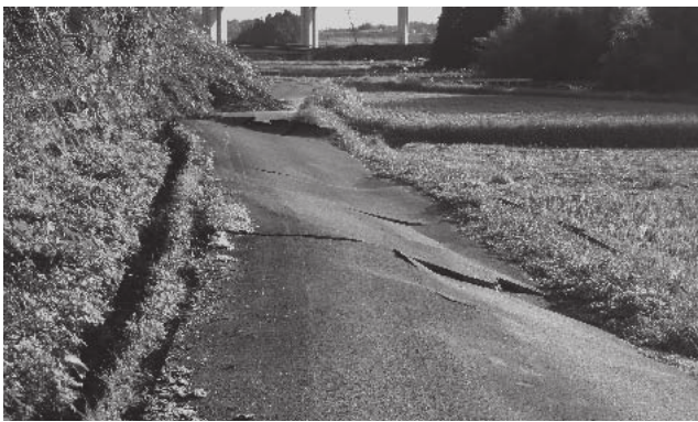
台風21号災害現場 (甲南町竜法師地先)
