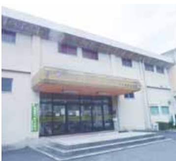
老朽化した水口体育館
